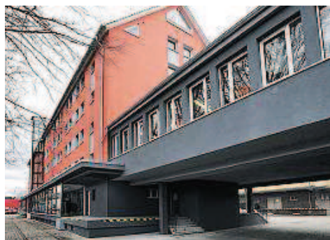
Modern wurden Verbindungsbrücke zwischen den Häusern Nummer 80 und 68 sowie Schaufenster auf den ehemaligen Rampen gestaltet.
