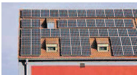
Eine 150 kW-Solaranlage wurde installiert.
