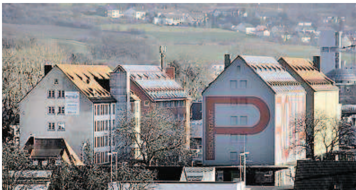
Das Ensemble des Proviantamts wurde grundlegend ertüchtigt.
