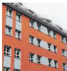
Neu eingezogene Fensterbänder.
